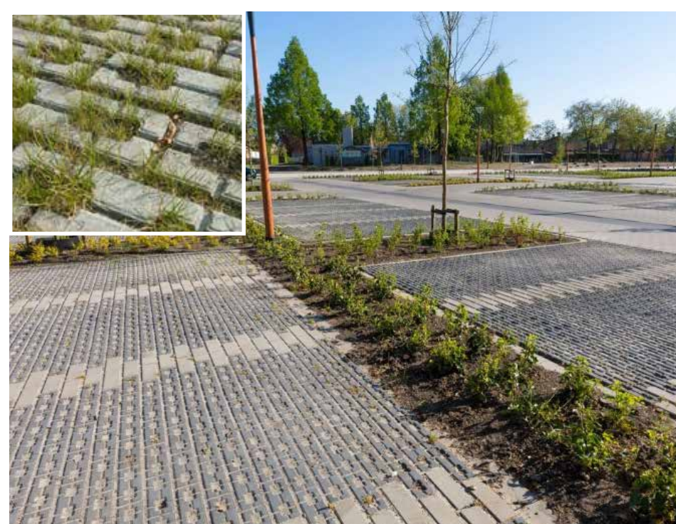
Parkeren op grasbetonstenen
